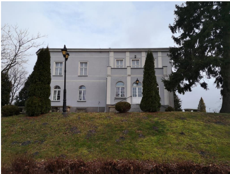
4. Elewacja boczna z murowaną werandą.
