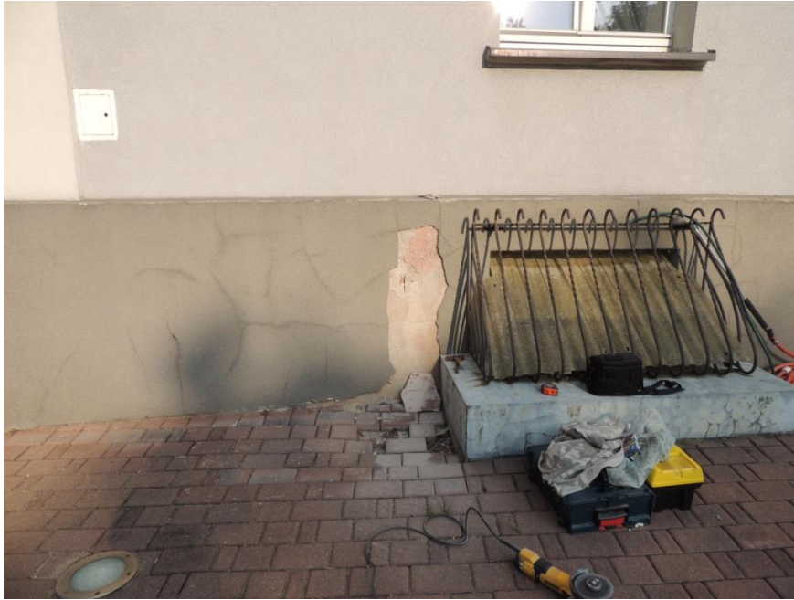
9. Doświetle okien piwnicy front.
