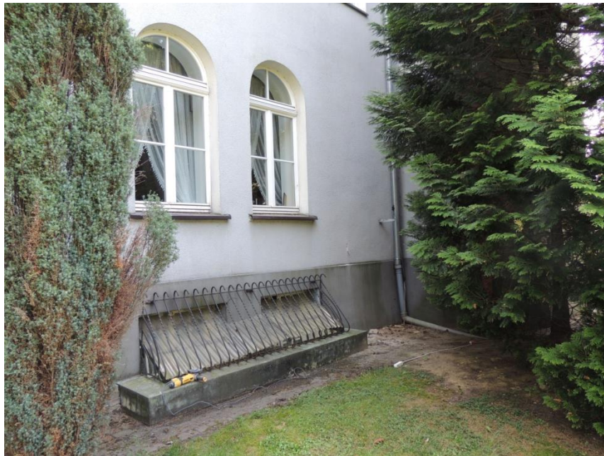
10. Doświetle okien piwnicy od strony parku.
