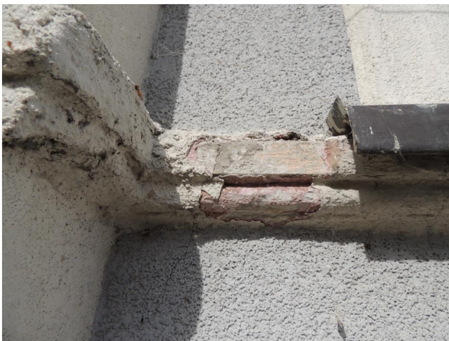
15. Zniszczony i zredukowany gzyms naścienny.
